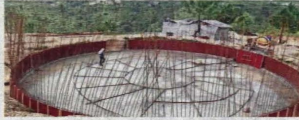
एनआइटी के सुमाड़ी परिसर में निर्माणाधीन पानी का बड़ा टैंक • जागरण
